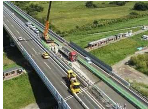
道央自動車道 夕張川橋の床版取替工事
