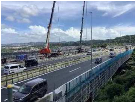
横浜横須賀道路 釜利谷第二高架橋の床版取替工事
